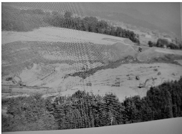
広島大学造成工事が始まる（昭和57年）
